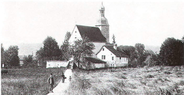
Die Umgebung der Loreto-Kapelle im Grüngürtel um die Solothurner Altstadt wurde durch Landerwerb geschützt.
