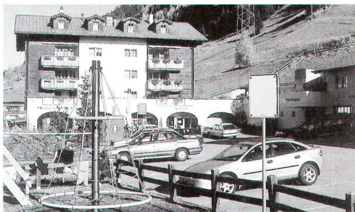
Ci-dessus: En décembre 1996, les installations de sport ouvrent à Elm une nouvelle télécabine, dans le domaine skiable du Kärpf. Ci-dessous: A l'entrée est du village d'Ernen surgit un petit centre comprenant école, place de jeu pour enfants, hôtel et parc à voitures.
