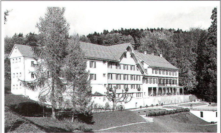
Vom 17. Jahrhundert bis heute ist der Gasthof Gyrenbad in Turbenthal in mehreren Etappen erweitert worden. (Bild Hochbauamt des Kantons Zürich)
