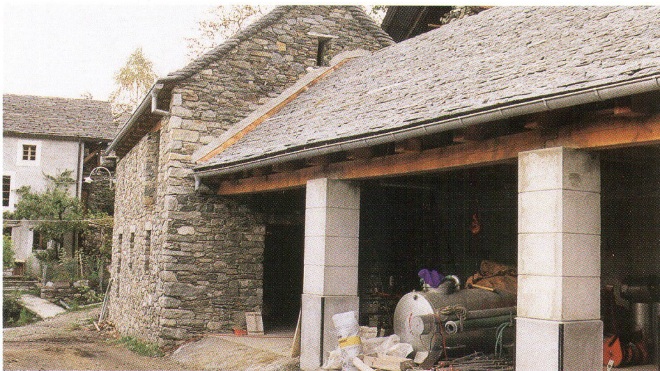
Diese vom FLS mitfinanzierte Sanierung von Ställen und Remisen in Bordei TI zeigt, dass Rücksicht auf regionale Bautraditionen und eine moderne Landwirtschaft zu vereinbaren sind. (Bild Stiftung Terra Vecchia)
