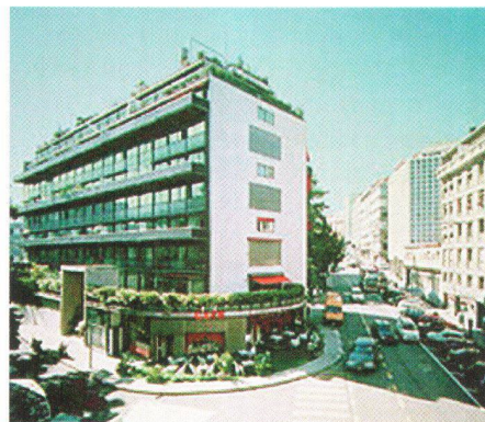
1931-32 von Le Corbusier und Pierre Jeanneret erstellt: das Haus Clarté in Genf. (Archivbild) L'immeuble Clarté à Genève édifié en 1931-1932 par Le Corbusier et Pierre Jeanneret (Archiv)
