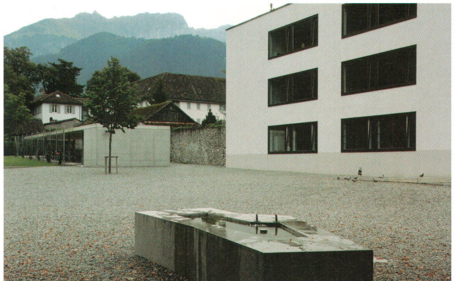
Die erweiterte Schulanlage St. Karl mit ihrem grosszügig gestalteten Pausenplatz (Bild SHS) L'école St. Karl agrandie et sa cour de récréation de dimensions généreuses (photo Ps)
