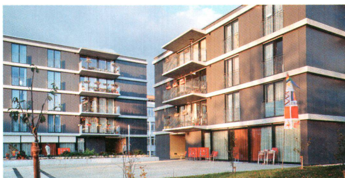
Construit en 2005-2007 (ARGE Bienne 97), le home avec foyer de jour pour personnes handicapées «Rodania» présente une architecture moderne empreinte de calme (Keystone/G. Bally)
