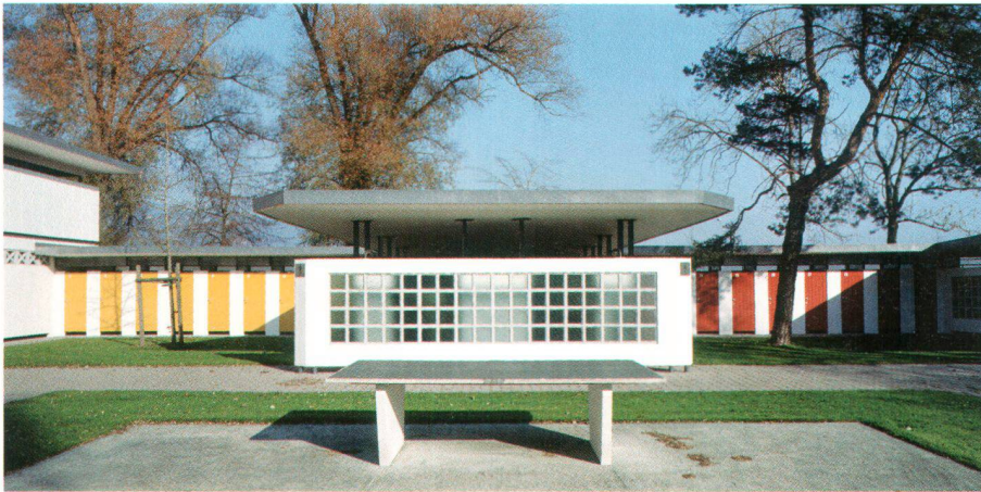
Das Grencher Schwimmbad von 1956 (Beda Hefti) wurde ab 1999 bis heute schrittweise saniert. Es ist ein Beispiel für den vernünftigen Umgang der diesjährigen Wakkerpreisgemeinde mit Bauten der 50er-Jahre. Die Anlage strahlt noch immer den Charme ihrer Zeit aus, genügt aber auch den heutigen Ansprüchen an ein Freibad (Bild Keystone/Gaëtan Bally)
