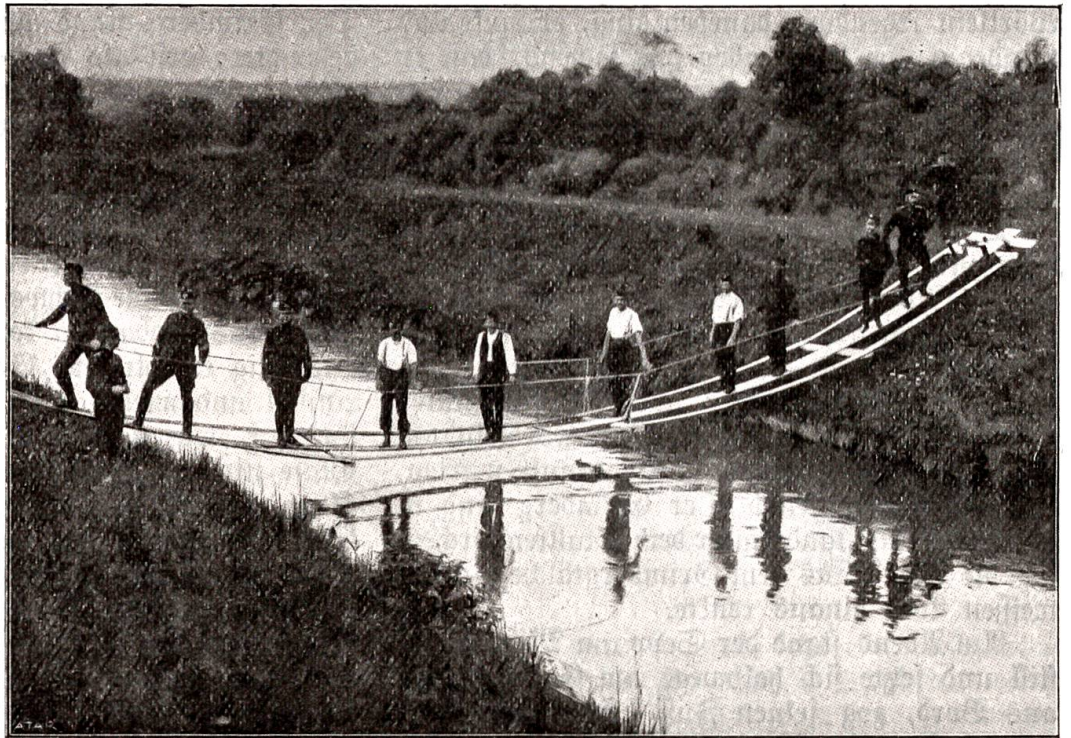
Herstellung einer fliegenden Brücke.
