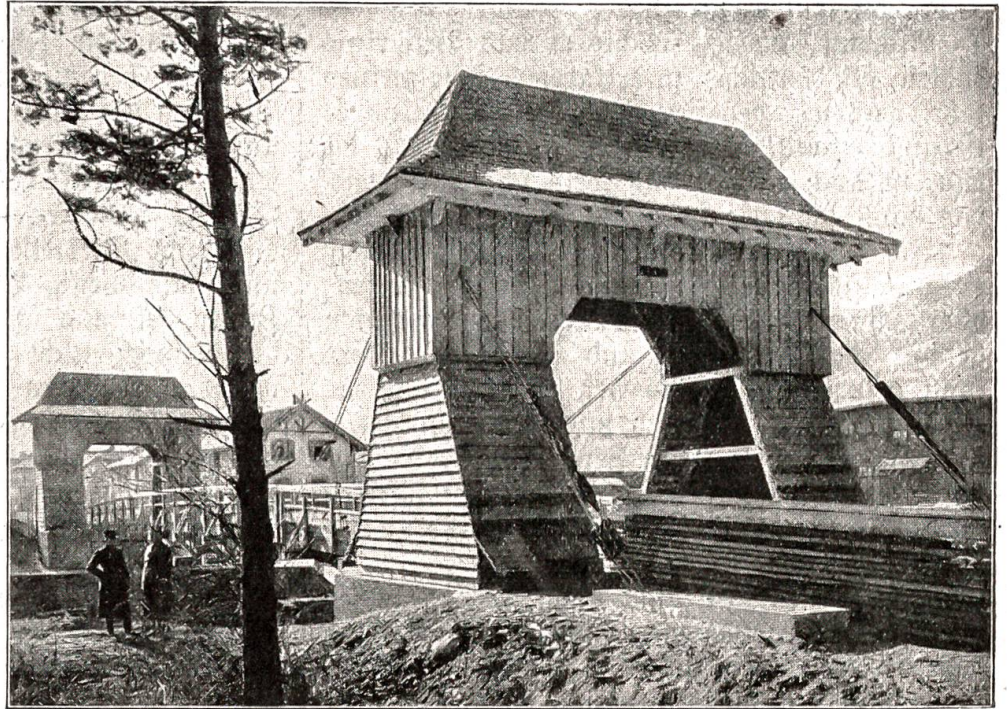
Durch Genietruppen erstellte Brücke in Landquart.
