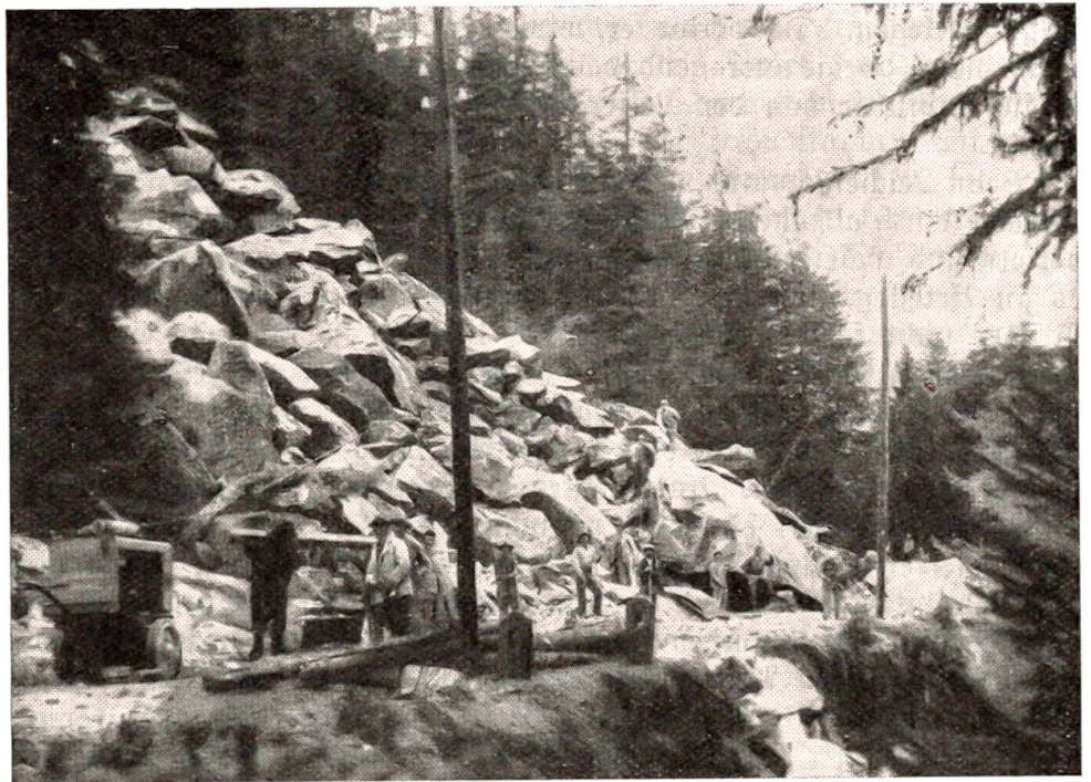
Felssturz bei der Via Mala. Photopress, Zürich.
