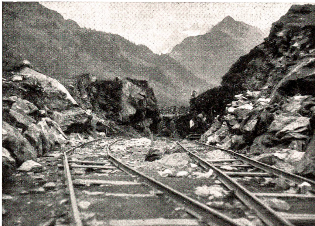
Bau der Sustenstraße.
