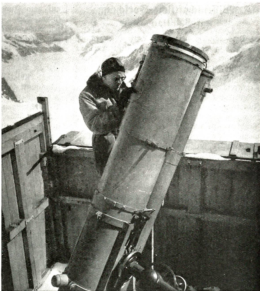
Das 1946 aufgestellte Spiegelteleskop für die Beobachtung der Sterne und der Sonne bei der Montage auf dem Dach des Sphinxobservatoriums
