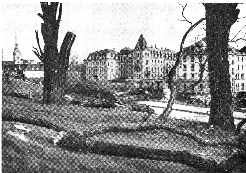
Baubeginn am neuen Berner Bahnhof
