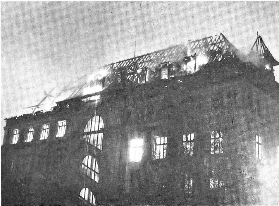
Brand in der Berner Kaserne Beschädigt wurden der Dachstuhl und das oberste Stockwerk des Südflügels.
