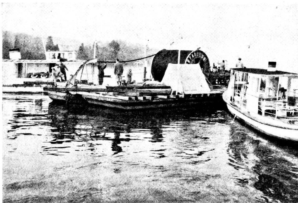
Im Februar 1962 verlegten die Bernischen Kraftwerke im Thunersee ein neues Starkstromkabel; es ist über dreieinhalb Kilometer lang und 61 Tonnen schwer. Zwei Dampfboote stoßen den Doppelponton mit der Kabelrolle.
