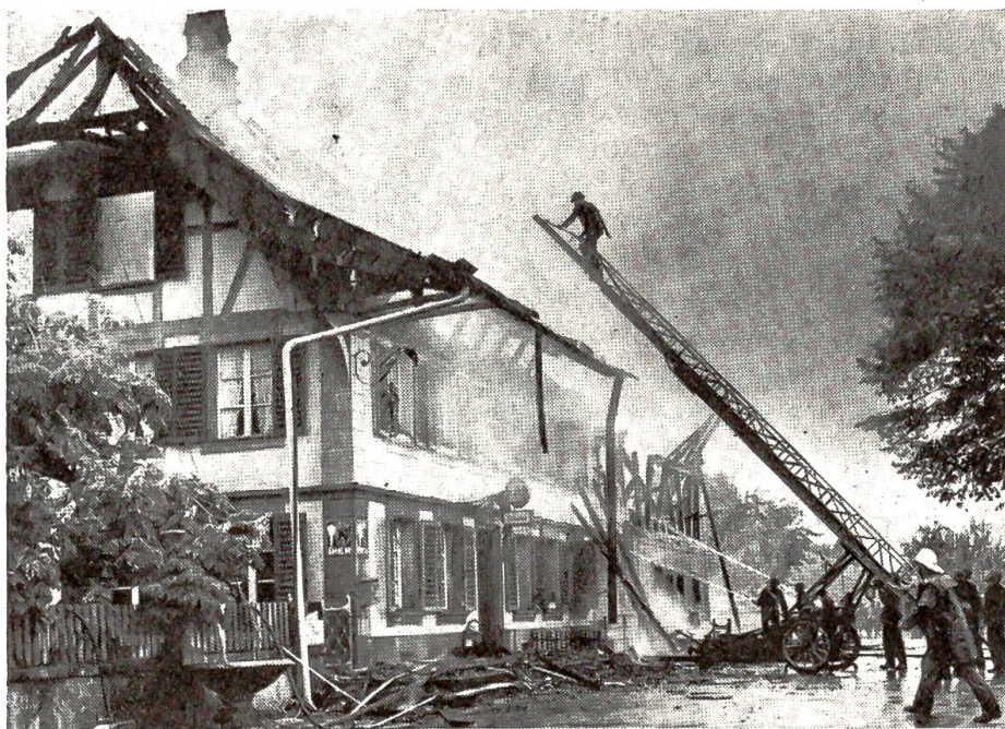
Großbrand in Belp
