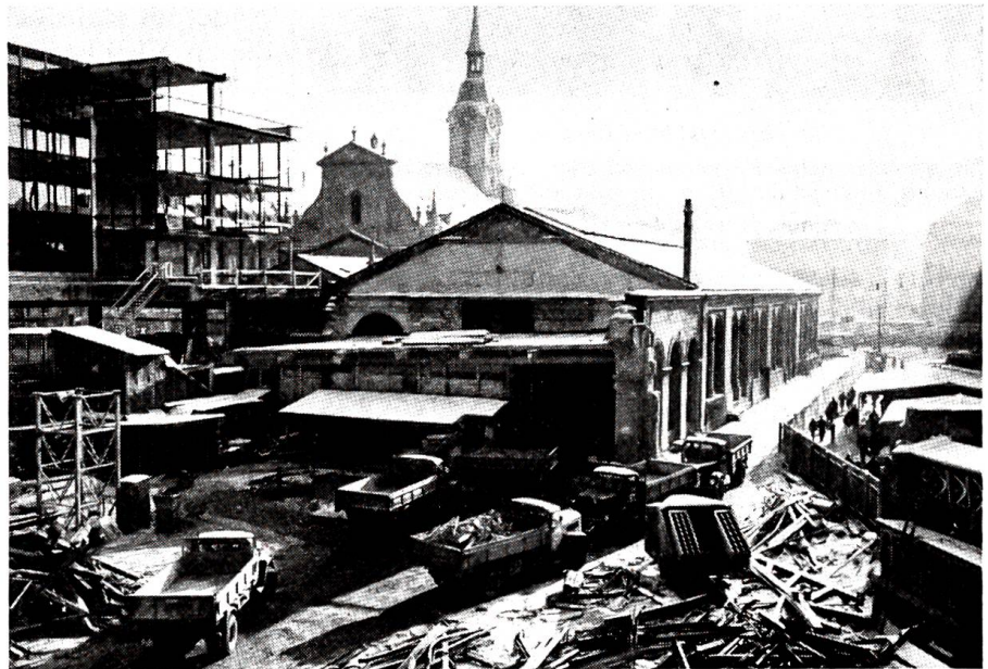
Neubau des Berner Hauptbahnhofs
