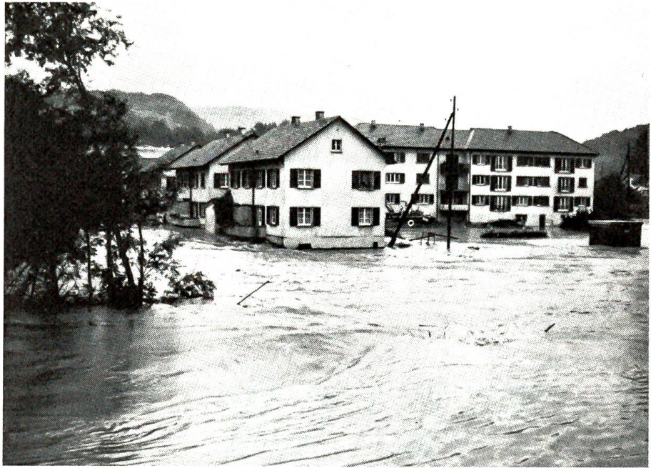
Schwere Überschwemmungen im Birstal
