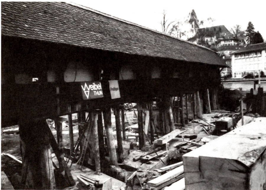
Die Scherzligenschleuse in Thun wird saniert
