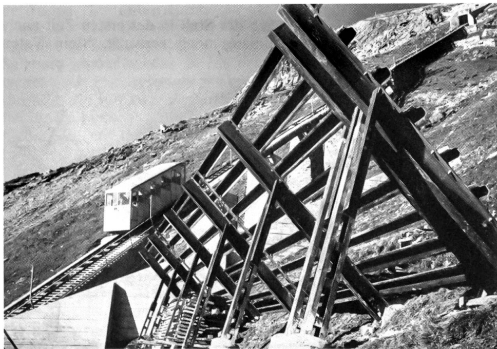
Lawinenverbauungen am Niesen
