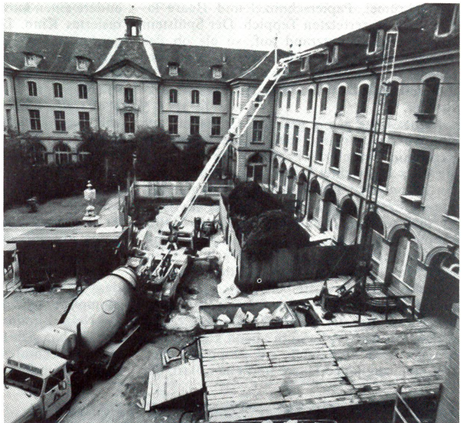
Innenrenovation des Burgerspitals in Bern
