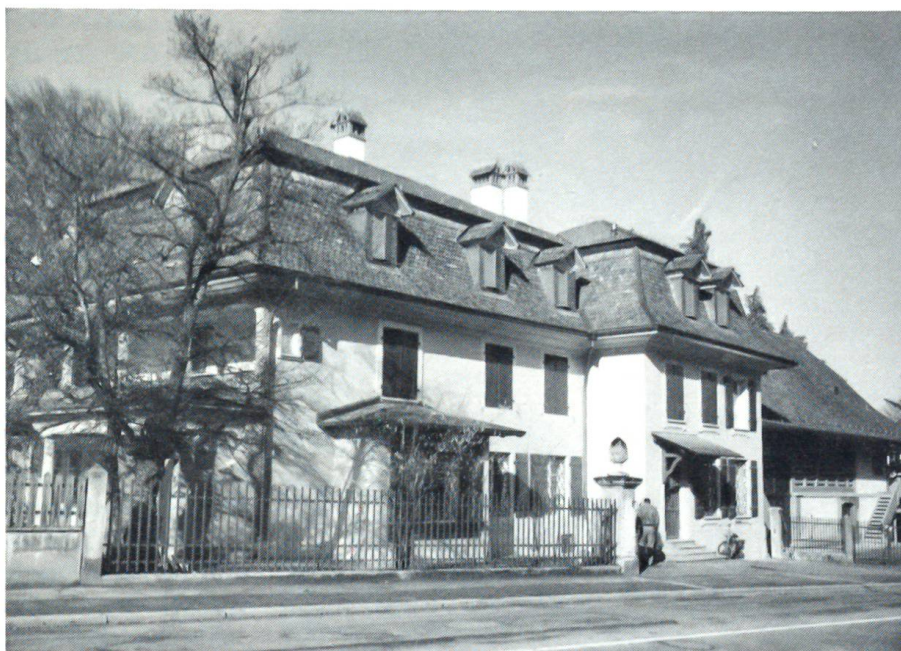
Campagne Rosenberg renoviert
