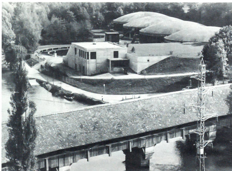
ARA Neubrücke ausgebaut
