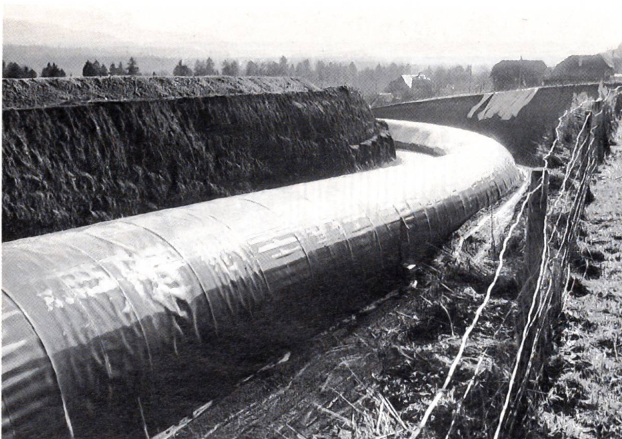
Imposanter Strassenbau in Jaberg BE
