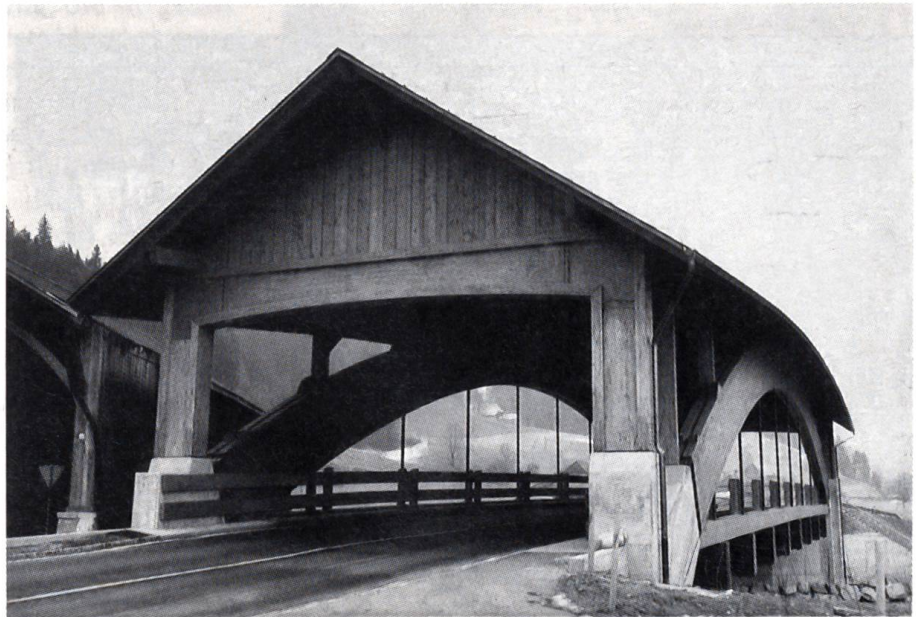
Schönheit im Brückenbau
