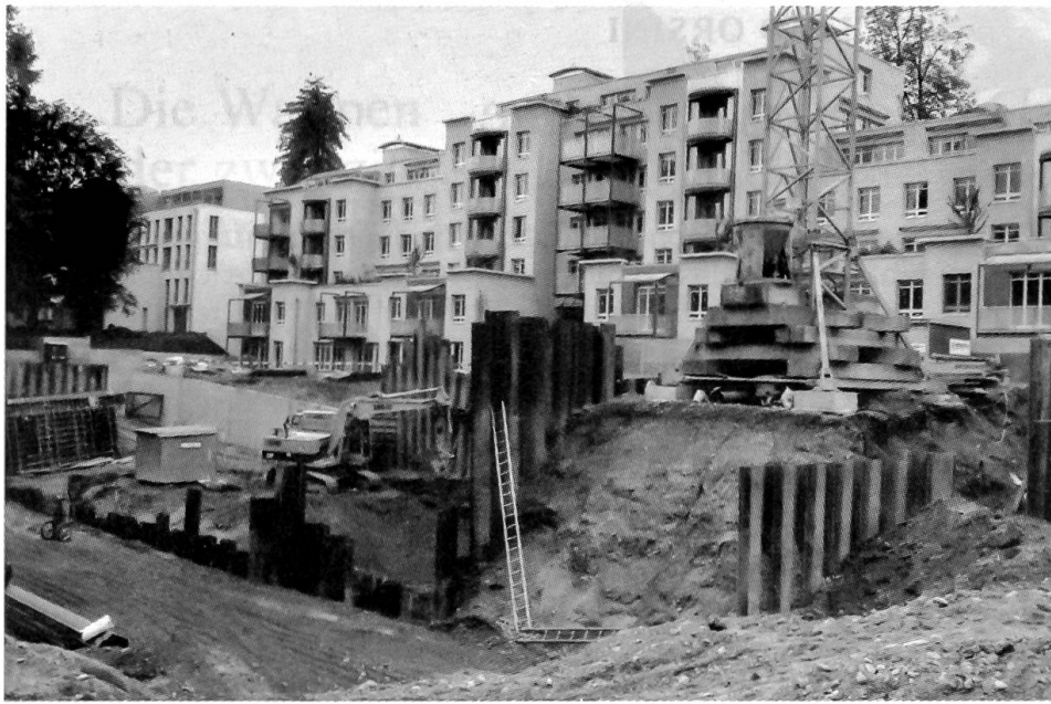
Grossbaustelle im Berner Vilette-Quartier
