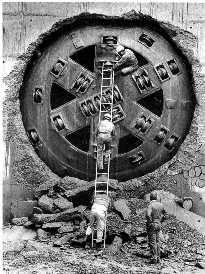
SBB-Grossbaustelle im Grauholz – Durchstich im Grauholztunnel
