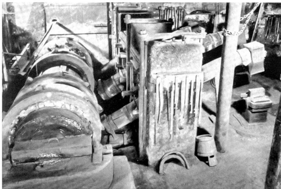
Der direkt vom Wasserrad getriebene Wellbaum mit den Nockenringen und der Hammerstuhlung mit den drei Schwanzhämmern. Die letzte der ursprünglich drei Anlagen des 17. Jh.
