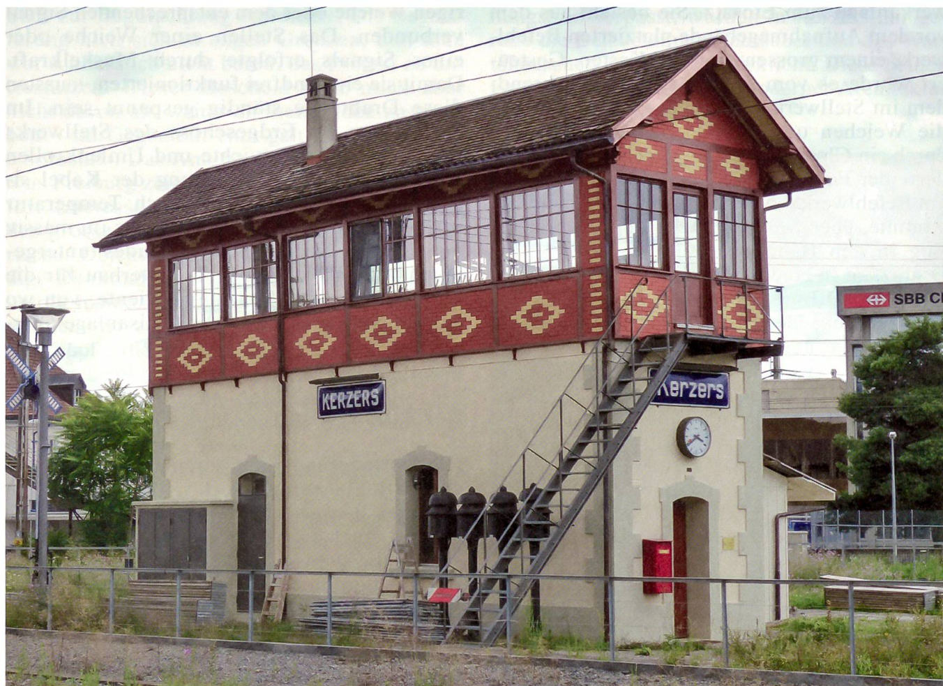
Das 1901 erbaute Stellwerkgebäude
