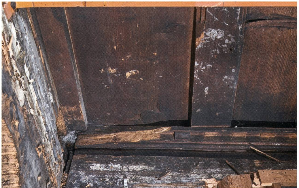
Abb. 8: Flüelen, Axenstrasse 2. Die Stube des ersten Wohngeschosses. Südwestecke, Blick nach oben. Die Bohlen-Balken-Decke liegt auf einem mit Konsolfries dekorierten Konsolbalken. Die Balken der Decke sind mit doppelt gekehlter Fase und Ablauf profiliert (Foto: Georg Sidler, Schwyz).
