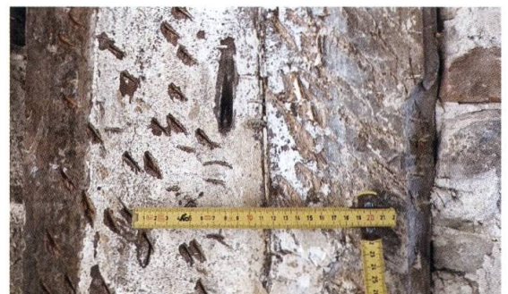
Abb. 6: Flüelen, Axenstrasse 2. Mittelgang. Blick gegen Westen. Flämmchenförmige Brandspur auf dem nördlichen Mantelstüd an der Türöffnung zur Stube (Foto: Ulrike Gollnick, BAB Gollnick).
