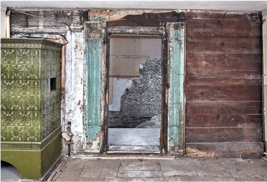
Abb. 13a und 13b: Flüelen, Axenstrasse 2. Hintere Stube. Blick gegen Westen. Türöffnung mit kanneliertem Mantelstud (Fotos: Georg Sidler, Schwyz).
