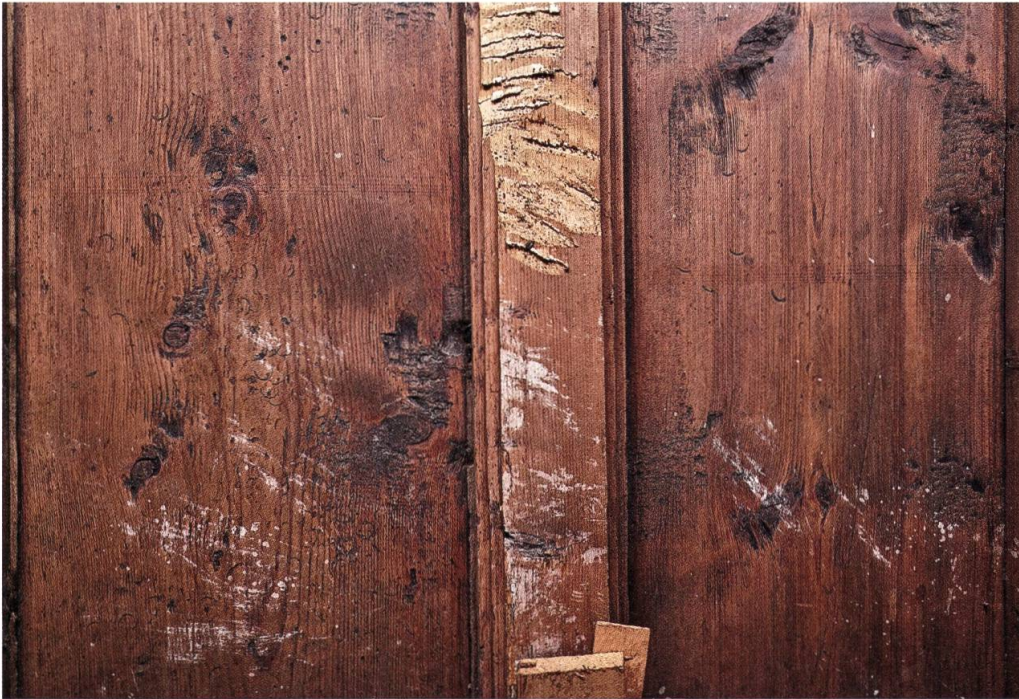
Abb. 9: Flüelen, Axenstrasse 2. Die Stube des ersten Wohngeschosses. Decke. Blick nach oben. Profilierte Balken und Bohlen mit eingedrücktem Streifendekor (Foto: Georg Sidler, Schwyz).
