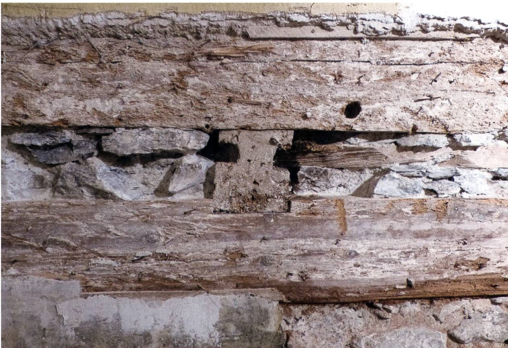
Abb. 10: Flüelen, Axenstrasse 2. Mittelgang. Blick gegen Westen. Sondierung 1. Durchstossende Balken der Bohlen-Balken-Decke des Sockelgeschosses. Die seitliche Nut dient zur Aufnahme der Bohlen (Foto: Georg Sidler, Schwyz).
