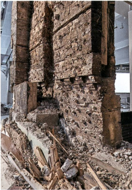
Abb. 17: Flüelen, Axenstrasse 2. Westfassade. Doppelreihiger Konsolfries unter den Fensteröffnungen des ersten Vollgeschosses. Blick gegen Norden (Foto: Georg Sidler, Schwyz).
