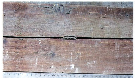
Abb. 5: Flüelen, Axenstrasse 2. Sogenannter Banndübel in einem Schwundriss (Foto: Ulrike Gollnick, BAB Gollnick).
