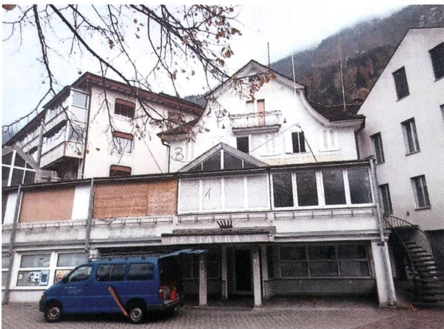
Abb. 2: Flüelen, Axenstrasse 2. Westfassade. Das letzte Erscheinungsbild zeigt ein stattliches Gebäude mit mansardhaft geschwungenem Zwerchgiebel. Der zweigeschossige, oben geschlossene Vorbau stammt aus dem 20. Jh. (Foto: Laboratoire Romand de Dendrochronologie, Cudrefin).
