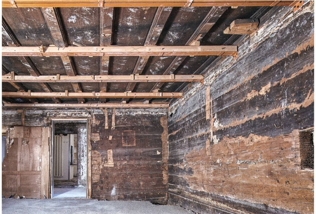
Abb. 7: Flüelen, Axenstrasse 2. Die Stube des ersten Wohngeschosses. Blick gegen Osten. Bohlen-Balken-Decke und Wände mit bauzeitlichem Anstrich (Foto: Georg Sidler, Schwyz).
