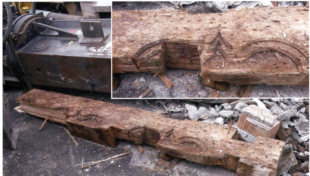
Abb. 15: Flüelen, Axenstrasse 2. Westfassade. Unterster Wandbalken der vorkragenden Fassade, dekoriert mit doppelt getreppten Kielbögen, die jeweils von einem Kreuz bekrönt werden. Einschnitt für die Eckverkämmung (rechts) (Foto während des Abbruches: Ulrike Gollnick, BAB Gollnick).
