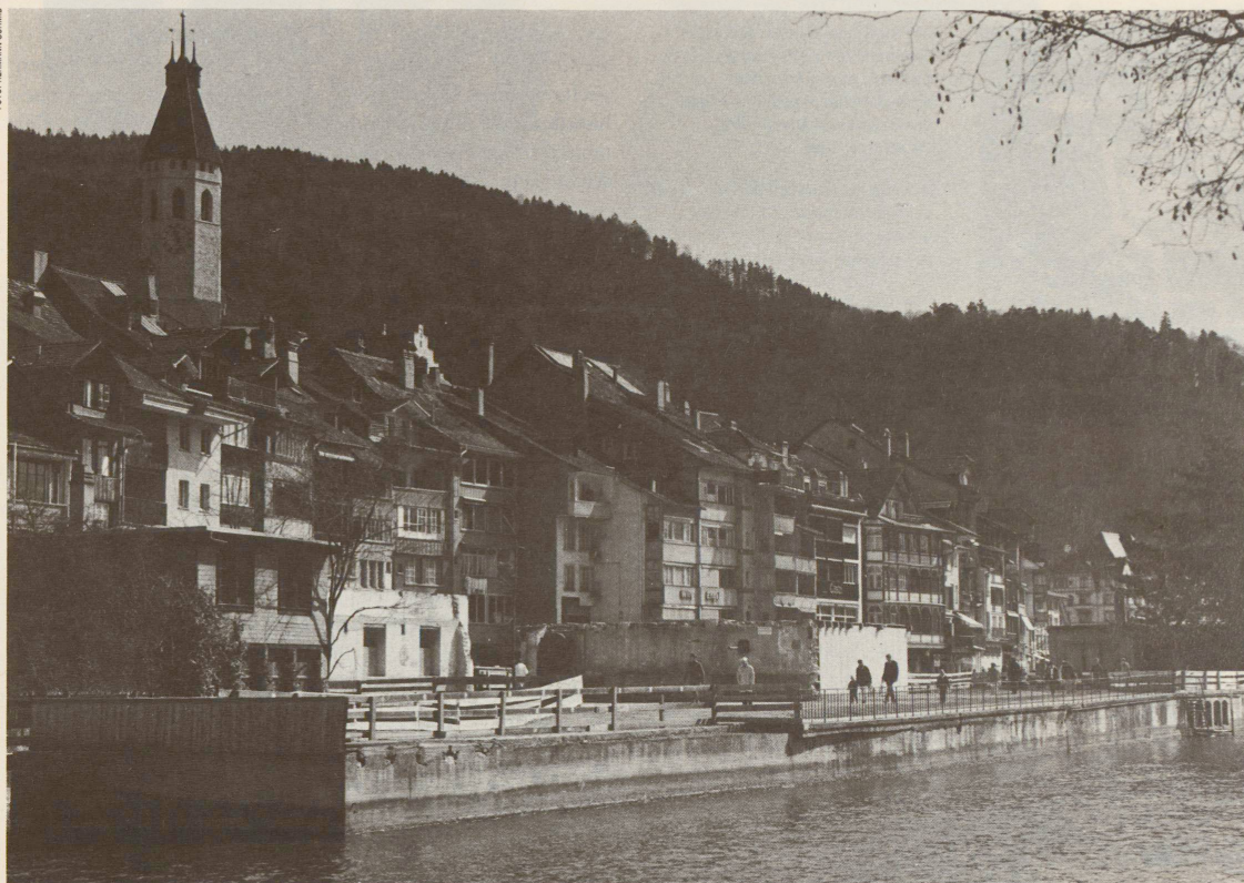
Das Thuner Mühleareal heute: Der mächtige Industriebau ist verschwunden, übrig bleibt das Turbinengehäuse.
