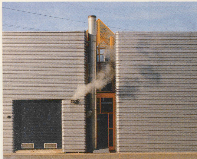
Werbepost an der Autobahn. 1981 verwirklichten Vichet und Ray direkt an der N12 eines der ersten Gewerbezentren der Schweiz (auf dem Plan Seite 67 rosa). Erstmals verwendeten sie ihr spezielles Verfahren für die Biegung von Profillechen. Der Werbeeffect blieb nicht aus. Inzwischen wurde diese Aussenhaut für 600 Industrie- und Gewerbebauten der Westschweiz verwendet.
