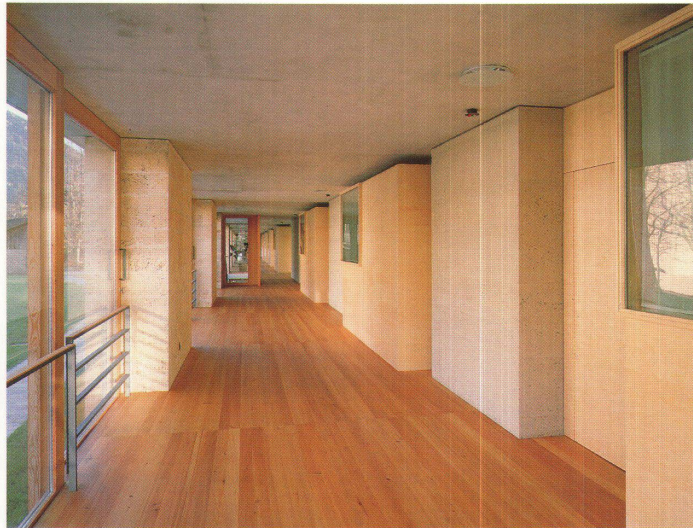
Blick in den Laubengang: rechts die tragenden Tuffsteinhüllen der Badezimmer, die mit den Holzkisten der Küchen abwechseln. In die Kisten ist ein Küchenfenster gebaut
