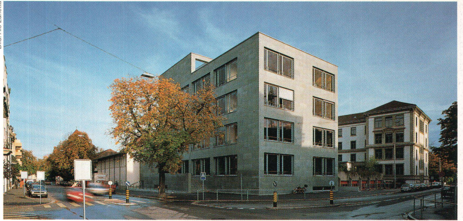
Der grünschimmernde Neubau übernimmt die Höhe des St. Johann-Schulhauses
