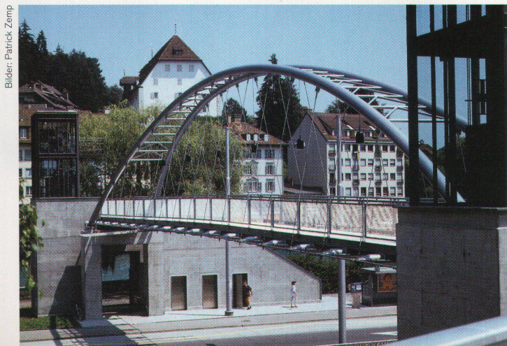
Zwischen zwei massiven Mauerscheiben (Pylonen) spannt sich die Leichtkonstruktion der Brücke. Die Auflager werden als «Traggestell» besonders betont
