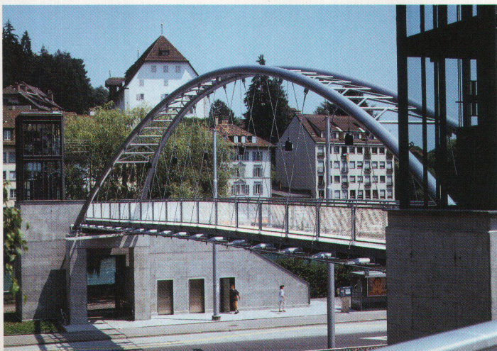
Zwischen zwei massiven Mauerscheiben (Pylonen) spannt sich die Leichtkonstruktion der Brücke. Die Auflager werden als «Traggestell» besonders betont
