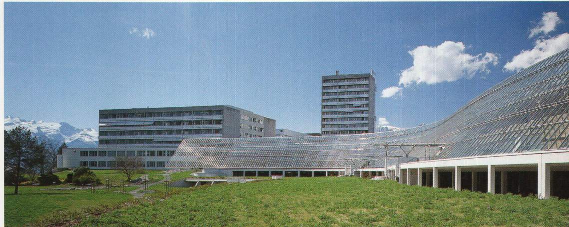
Ein Glas-Stahl-Band: Die Erweiterung des Landesklinikums von Feldkirch
