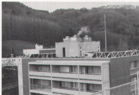
Solaranlage zur Warmwasservorwärmung
