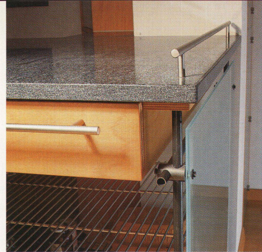
Sorgfalt der Konstruktion und alltägliche Brauchbarkeit: Ein Rohrgestüt trägt die Arbeitsfläche, und ein «Geländer» verhindert das Herabfallen von Gegenständen
