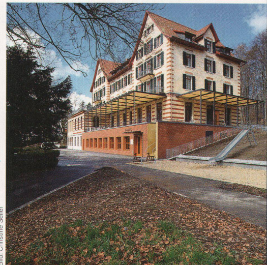
Das Kurhaus Zürichberg von 1900 und der daruntergeschobene neue Sockel von 1994 bilden ein neues Gleichgewicht
