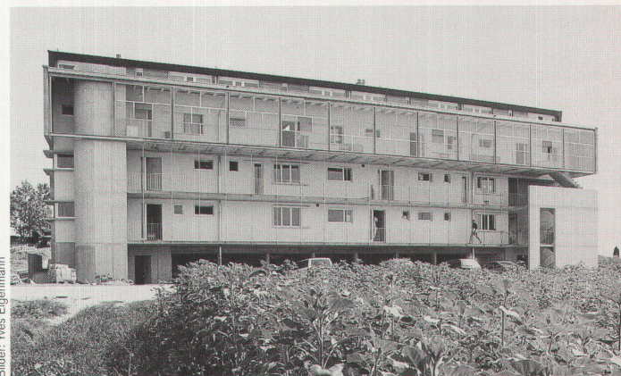
Die Nordfassade: Die verglaste Laube vor den Maisonnettewohnungen ist auch ein gedeckter Spielplatz
