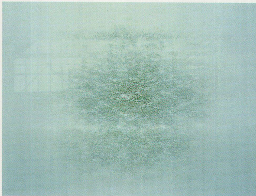
Die leuchtende Wand. Transparente Wärmedämmung aus der Nähe besehen
