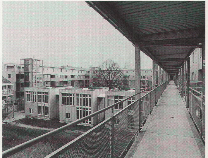
Die Wohnüberbauung Brahmshof in Zürich von Kuhn Fischer Partner
