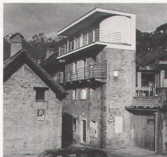
Das Turmhaus von Brenno Borradori in Gordola
