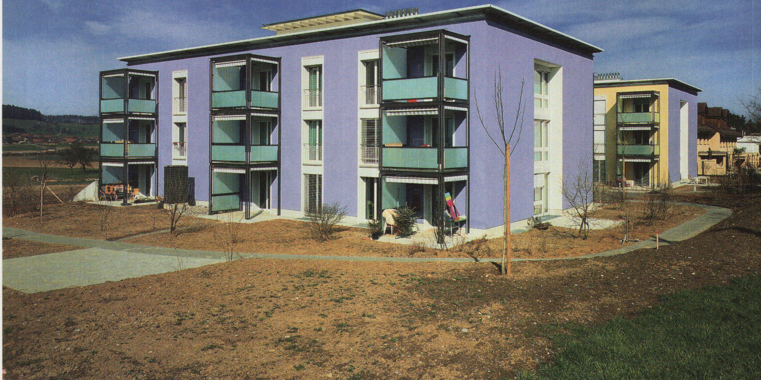
Die Balkone sind als selbsttragende Stahlkonstruktion vor die Fassade gestellt
