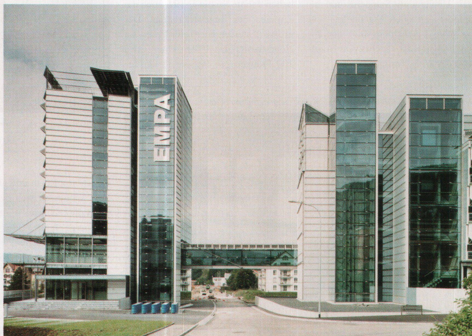
Blick von der Eingangsseite her auf die Senkrechten des Eingangs. Die Türme stehen beiderseits des «Landschaftstors». Am Fuss des Kopfs Roman Signers summendes Fasslager
