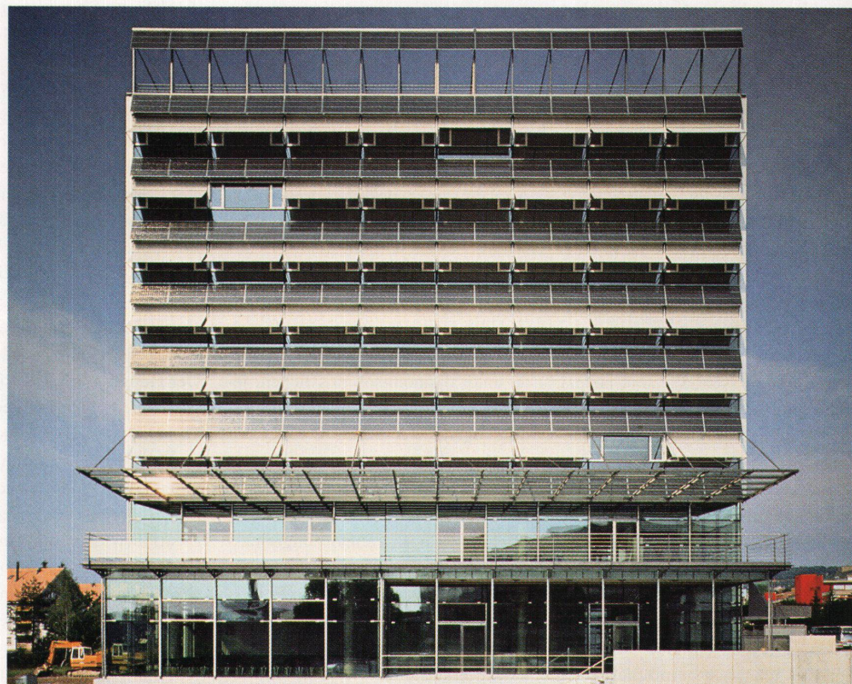
Westfassade des Kopfs. Auf dem Dach befindet sich eine Terrasse, wie auch im ersten Obergeschoss vor dem Aufenthaltsraum
