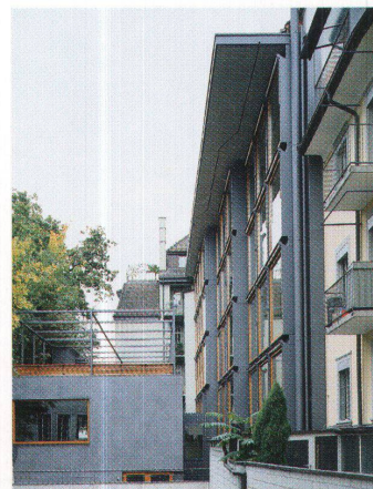
Hoffassade mit der vom bestehenden Bau stammenden Staffelung und dem frei gestellten Hofgebäude
