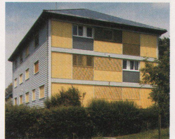
Ein banales Miethaus in Hedingen aus den sechziger Jahren vor und nach der Sanierung. Architekten: Lüschi und Züsli, Luzern
