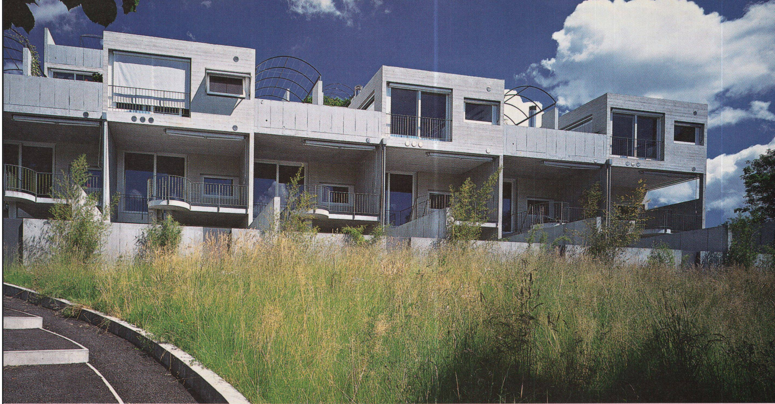
Die untere Reihenhauszeile kündigt dem Besucher die Siedlung an
