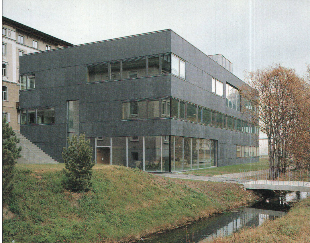
Blick auf die West- und Südfassade der neuen Höheren Fachschule für Tourismus
