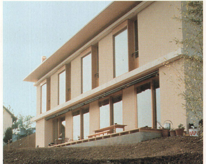
Ansicht Süd mit begehbaren Kastenfenstern
